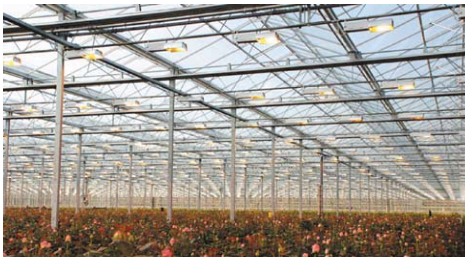
Рис. 5 Фрагмент ОУ со светильниками Galad
